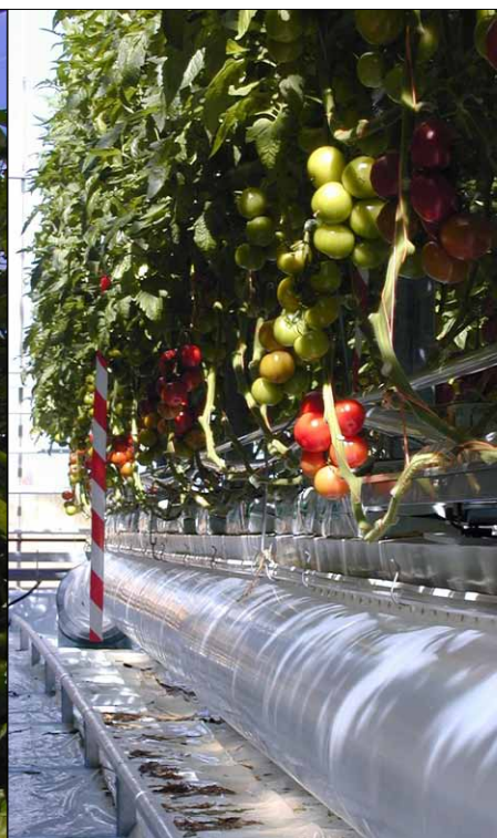
Gaine de distribution de surface
